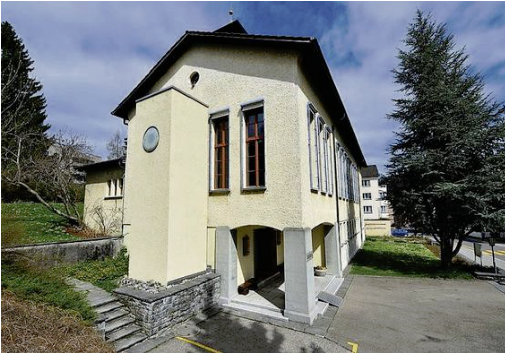
Das Kirchgemeindehaus an der Demutstrasse in St. Georgen. (Bild: Bild: Hanspeter Schiess)
